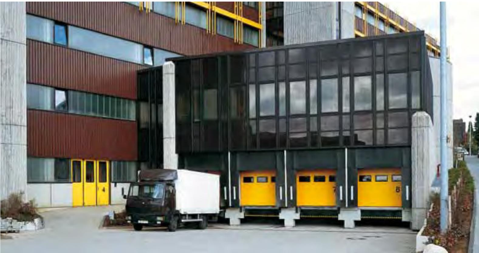
Durch ihre robuste Stahlausföhrung mit wärmegeklämmt Lamellen kommt dieses Tor in beheizten Hallen für den harten Alltagsbetrieb zum Einsatz. Die 40 mm dicken Lamellen sind für eine hohe Wärmedämmung mit PU-Hartschaum ausgeschäumt. Damit wird ein Wärmedämmwert von  $k = 1,0 \text{ W/m}^2\text{K}$  erreicht (eingebautes Tor 4 x 4 m ohne Verglasung).
